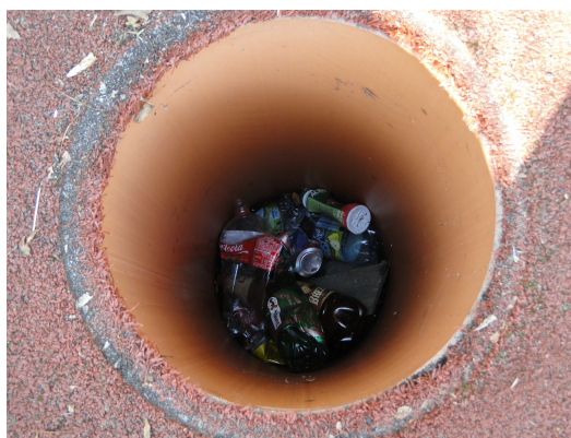
Obr. č. 3 Odpad v revizní šachtě drenáže
